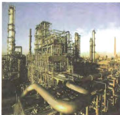
Рис. 50. Общий вид нефтеперегонного завода
